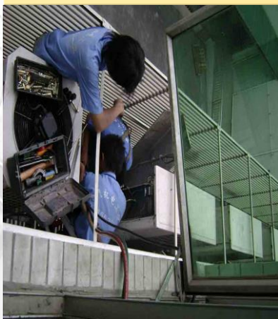
设备维修之间内部通信
